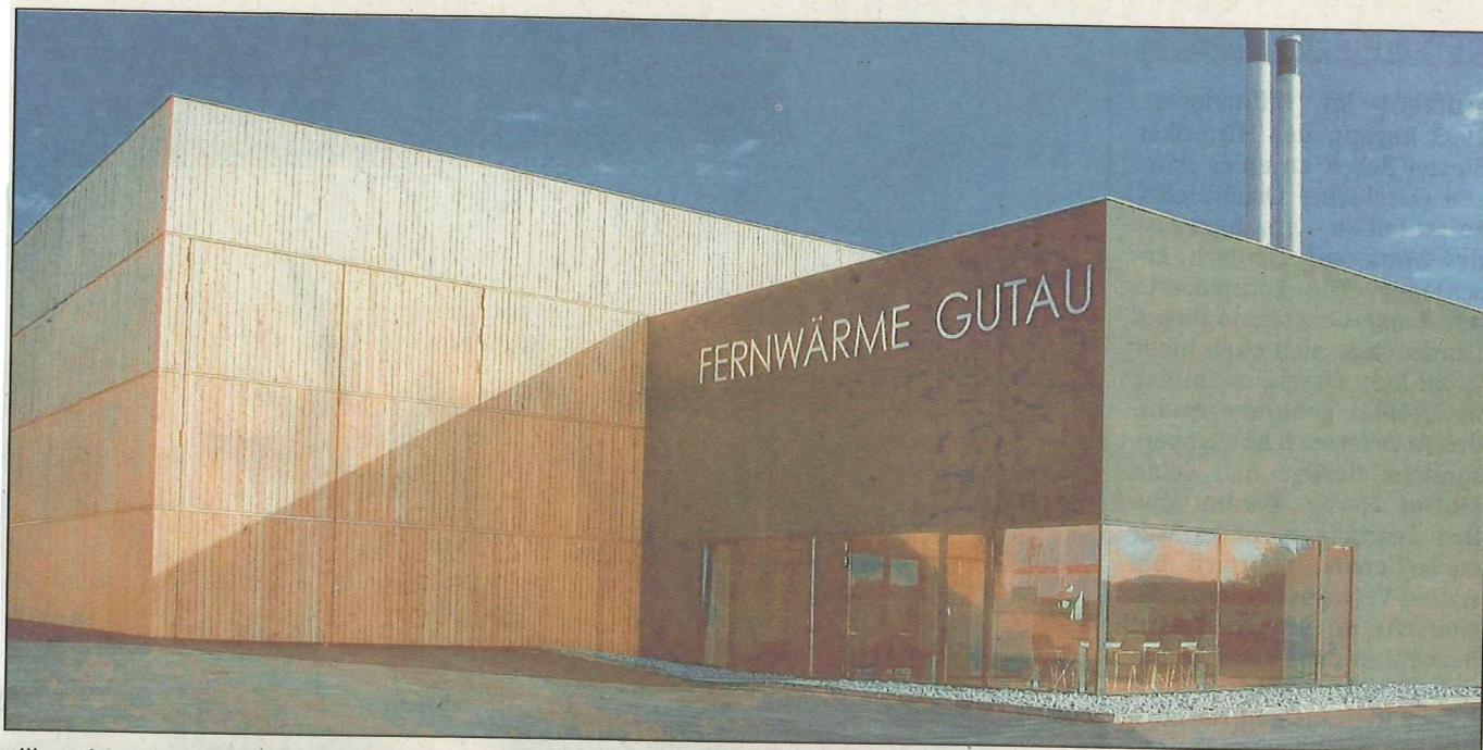
silberEines der neuesten Biomasse-Heizwerke Oberösterreichs: die Fernwärme Gutau.
